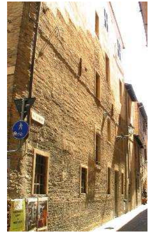
図11 外壁に見るオリジナルの痕跡
